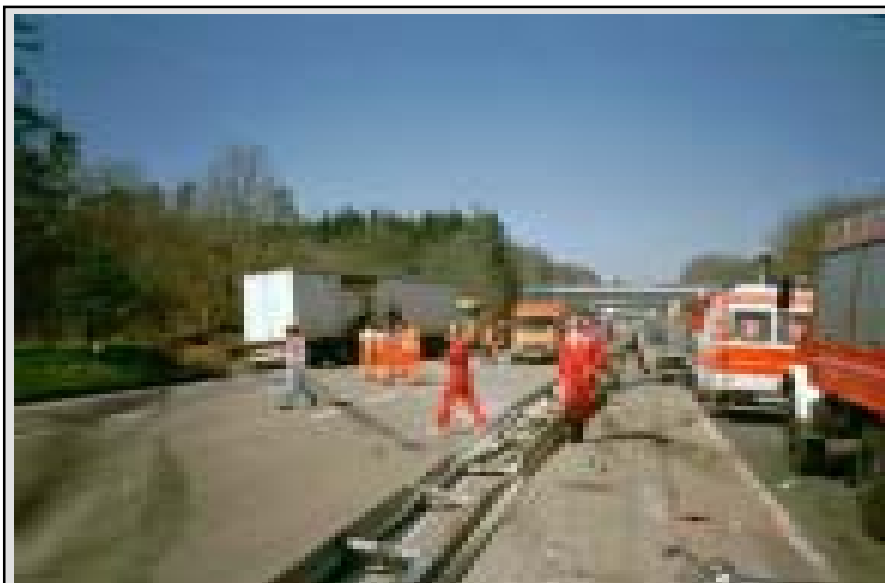
Erst nach Querung der Gegenfahrbahn kam der Sattelzug an der Böschung zum Stehen. Glücklicherweise kollidierte er nicht mit dem Gegenverkehr.
